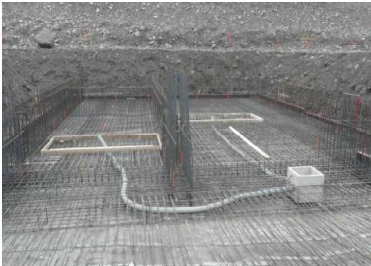
CENTRALE DI PRODUZIONE – POSA FERRO ARMATURA DI FONDAZIONE E CHIMATE
