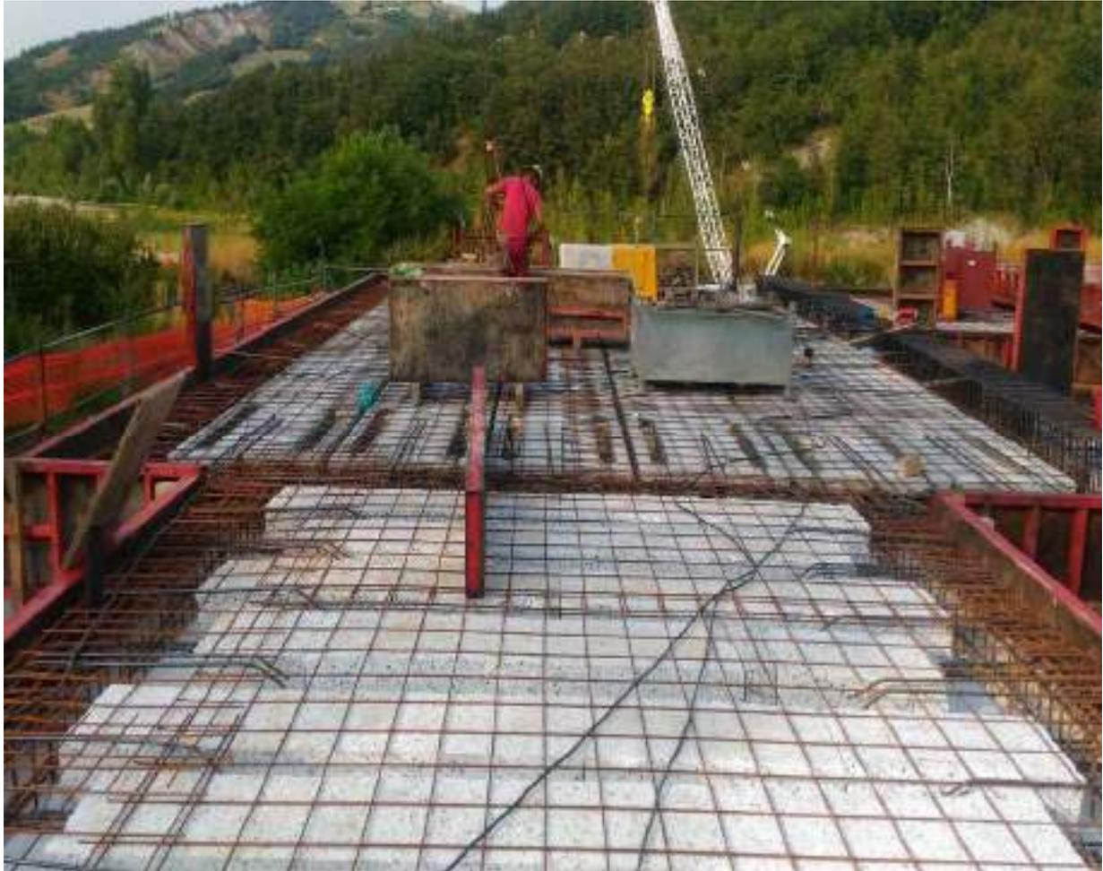
CENTRALE DI PRODUZIONE – POSA FERRO ARMATURA DEL SOLAIO DI COPERTURA
