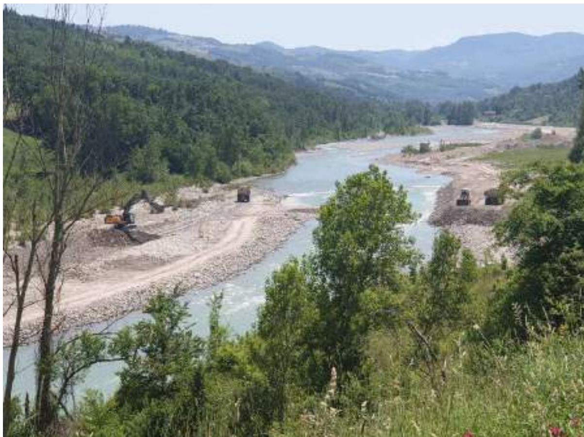
CANALE DI SCARICO A FIUME – FORMAZIONE ARGINE PROTEZIONE CANALE DI SCARICO
