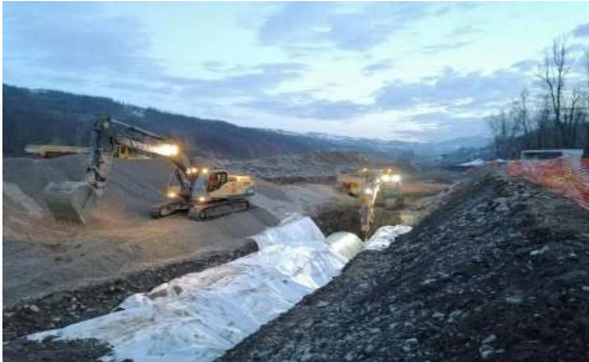
CONDOTTA FORZATA – FASE DI COPERTURA CON GEOTESSILE PRIMA DEL TOMBAMENTO
