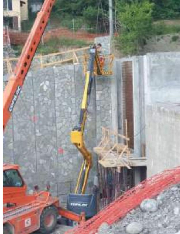
OPERA DI PRESA – FASE MONTAGGI LASTRE PREFABBRICATE DI RIVESTIMENTO PARAMENTO
