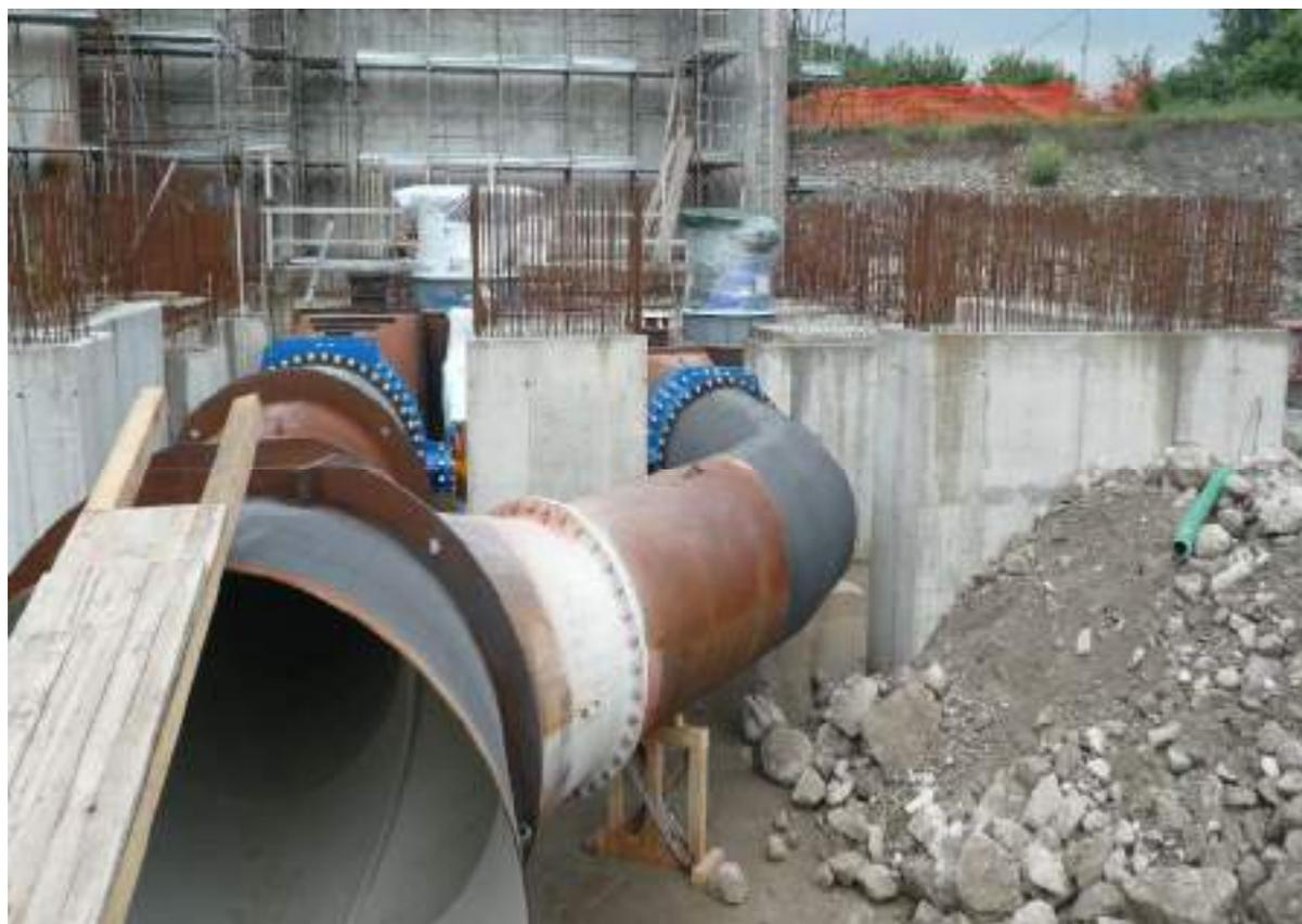
CENTRALE DI PRODUZIONE – POSIZIONAMENTO BIFORCATO VALVOLE E TURBINE
