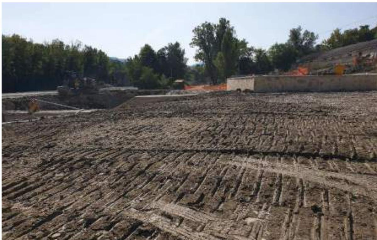
OPERA DI PRESA – INTERRAMENTO MANUFATTO DI DERIVAZINE E MODELLAZIONE DEL TERRENO
