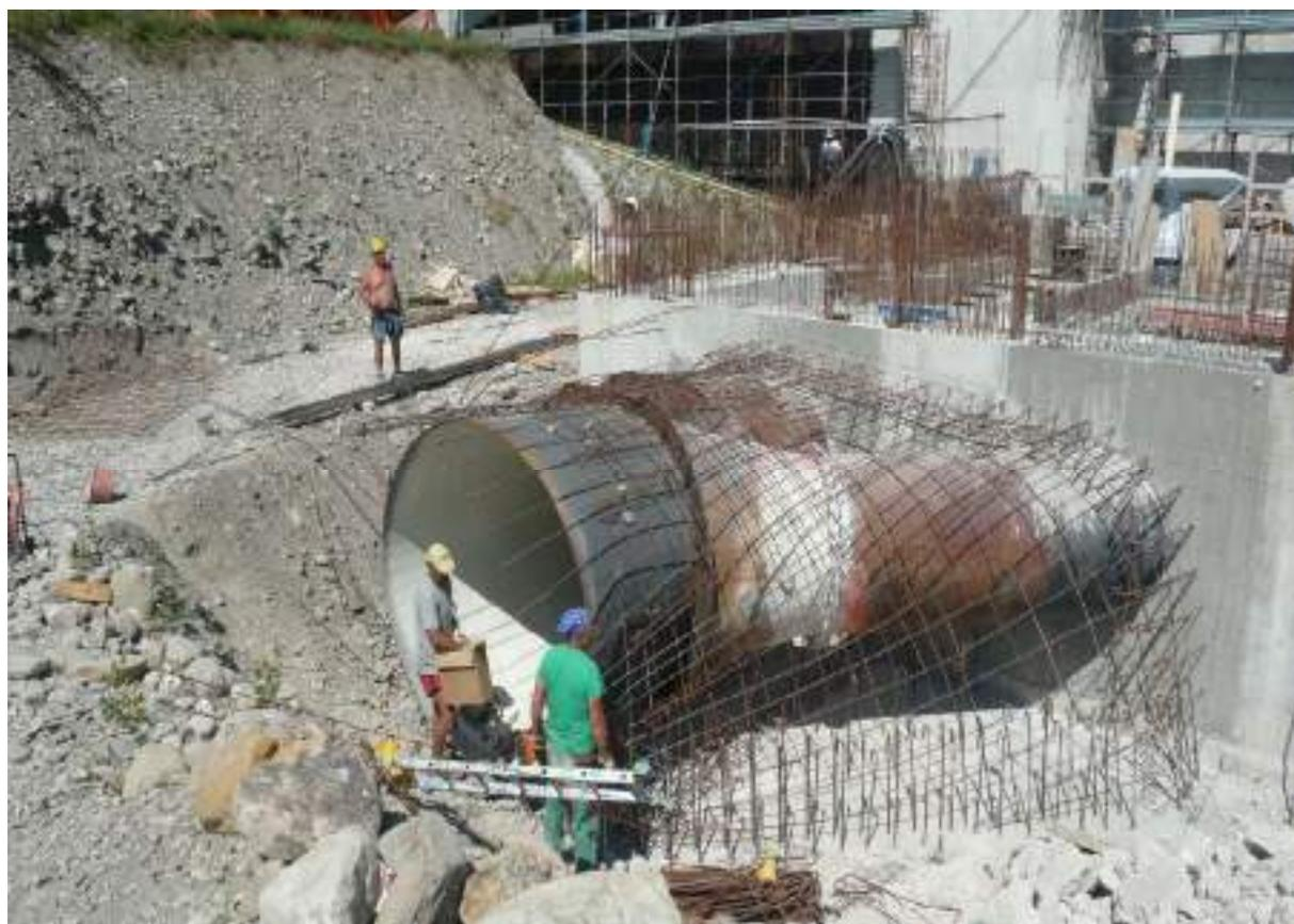
CENTRALE DI PRODUZIONE – MONTAGGIO FERRO ANCORAGGIO DEL BIFORCATO
