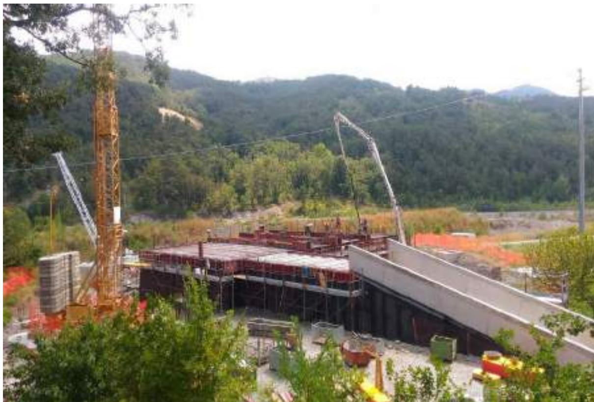
CENTRALE DI PRODUZIONE – GETTO SOLAIO DI COPERTURA VISTA DI INSIEME
