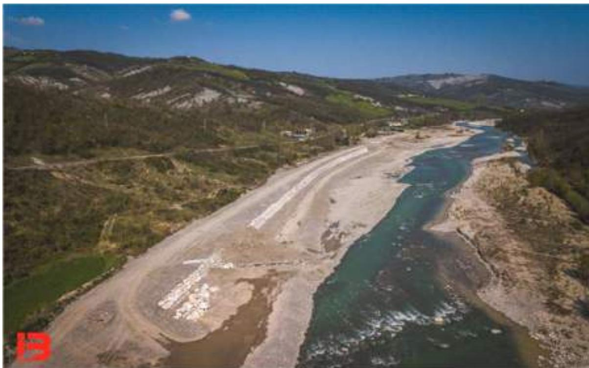
OPERE DI PROTEZIONE DELLA CODOTTA - VISTA AEREA MANTELLATA E RICOSTITUZIONE ARGINE
