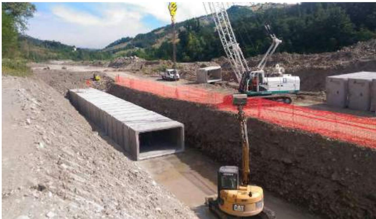
CANALE DI SCARICO - POSA DEGLI ELEMENTI SCATOLARI PREFABBRICATI
