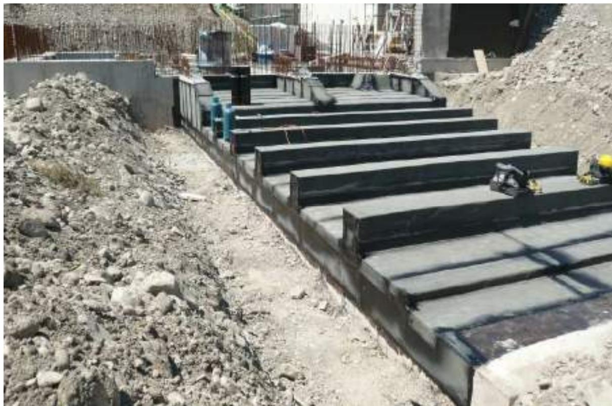
IMPERMEABILIZZAZIONE DELLA SOLETTA DI COPERTURA DEL CANALE DI SCARICO A VALLE DELLE TURBINE
