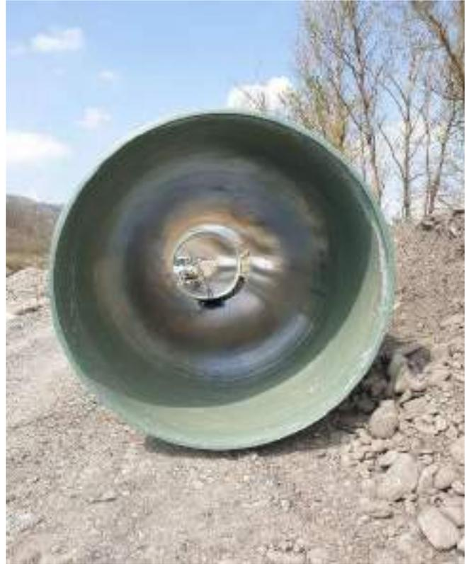
CONDOTTA FORZATA –FLANGIA ACCOPPIAMENTO TUBAZINE IN ACCIAIO E STOCCAGGIO TUBAZIONI
