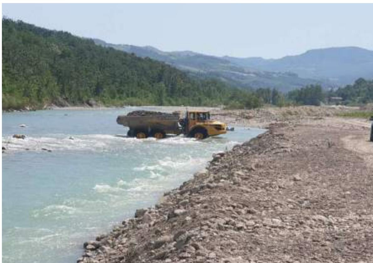
CANALE DI SCARICO A FIUME – GUADO - FORMAZIONE ARGINE PROTEZIONE CANALE DI SCARICO
