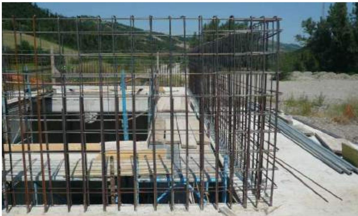
VASCA DI CARICO E DISSABBITORE – MONTAGGIO FERRO DI ARMATURA MURI CONTENIMENTO
