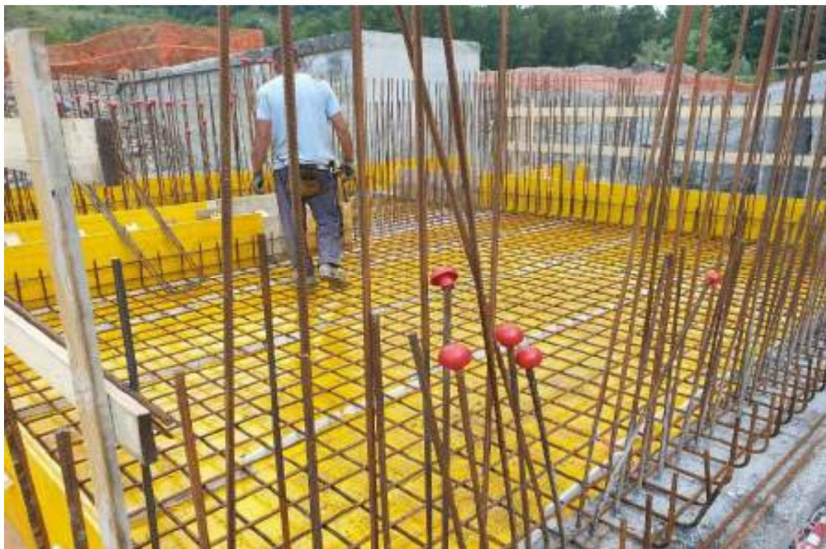
OPERA DI PRESA – POSA FERRO DI ARMATURA I° SOLAIO
