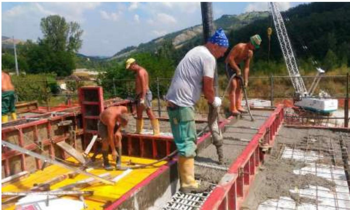
CENTRALE DI PRODUZIONE – GETTO SOLAIO DI COPERTURA
