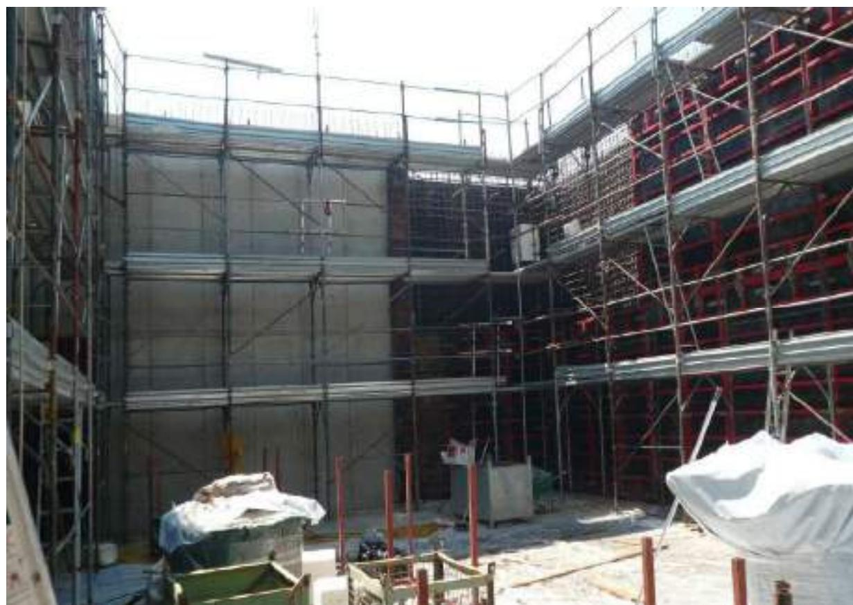
CENTRALE DI PRODUZIONE – VISTA DALL'INTERNO - PONTEGGI PER MONTAGGIO CASSERI
