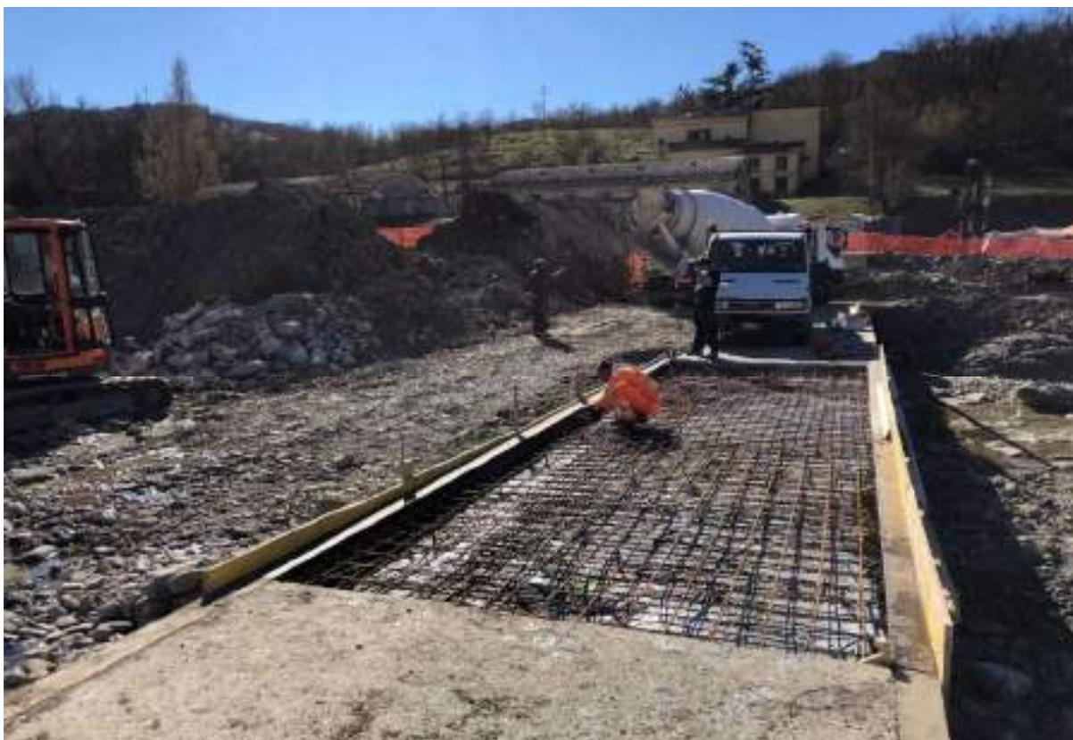
TRAVERSA DI PONTE SAMONE – POSIZIONAMENTO DELLE GABBIE DI FERRO DI ARMATURA II° FASE
