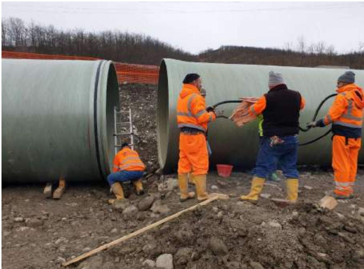
CONDOTTA FORZATA – FASE DI ALLOGGIAMENTO SUL MASCHIO DEL DOPPIO O-RING DI TENUATA
