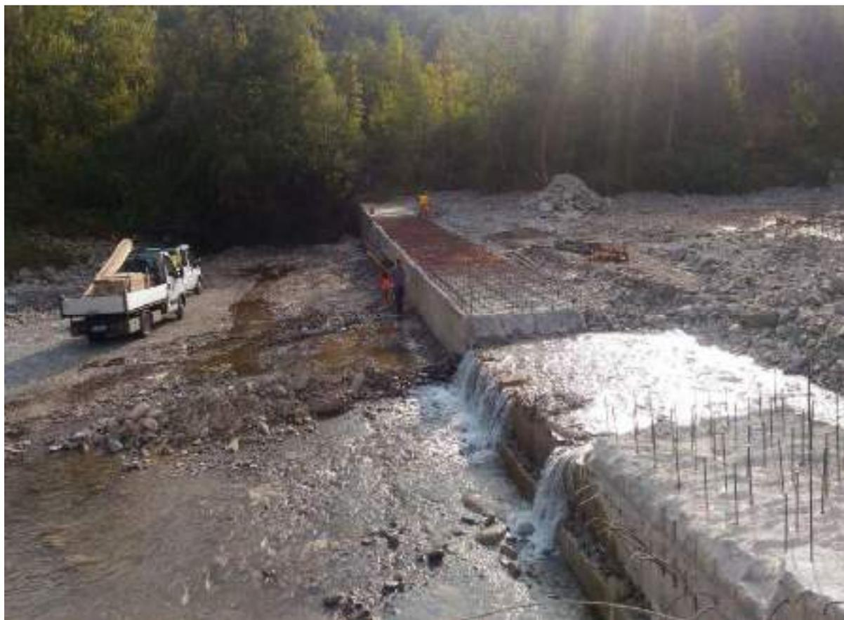
TRAVERSA DI PONTE SAMONE – POSIZIONAMENTO DELLE GABBIE DI FERRO DI ARMATURA I° FASE
