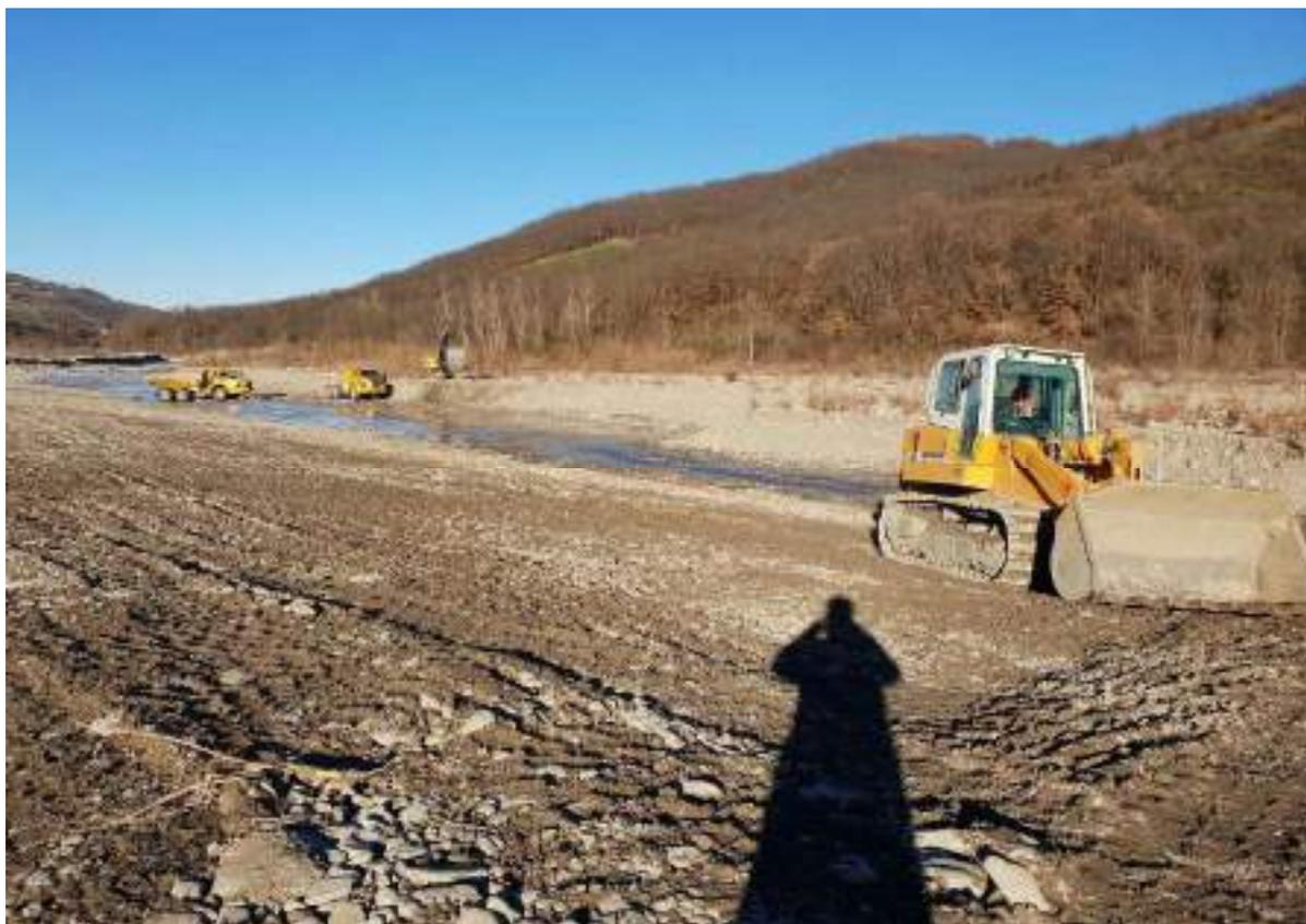
OPERE DI PROTEZIONE DELLA CODOTTA FORZATA –FORMAZIONE ARGINATURA ED ESCAVAZIONE IN ALVEO
