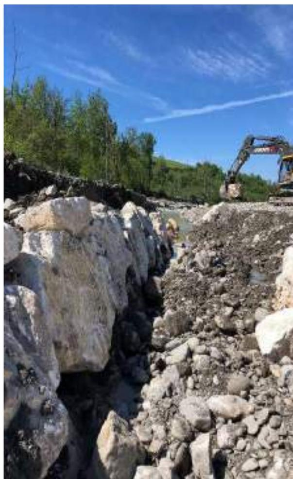
CANALE DI SCARICO A FIUME – SCOGLIERE DI PROTEZIONE CANALE DI SCARICO
