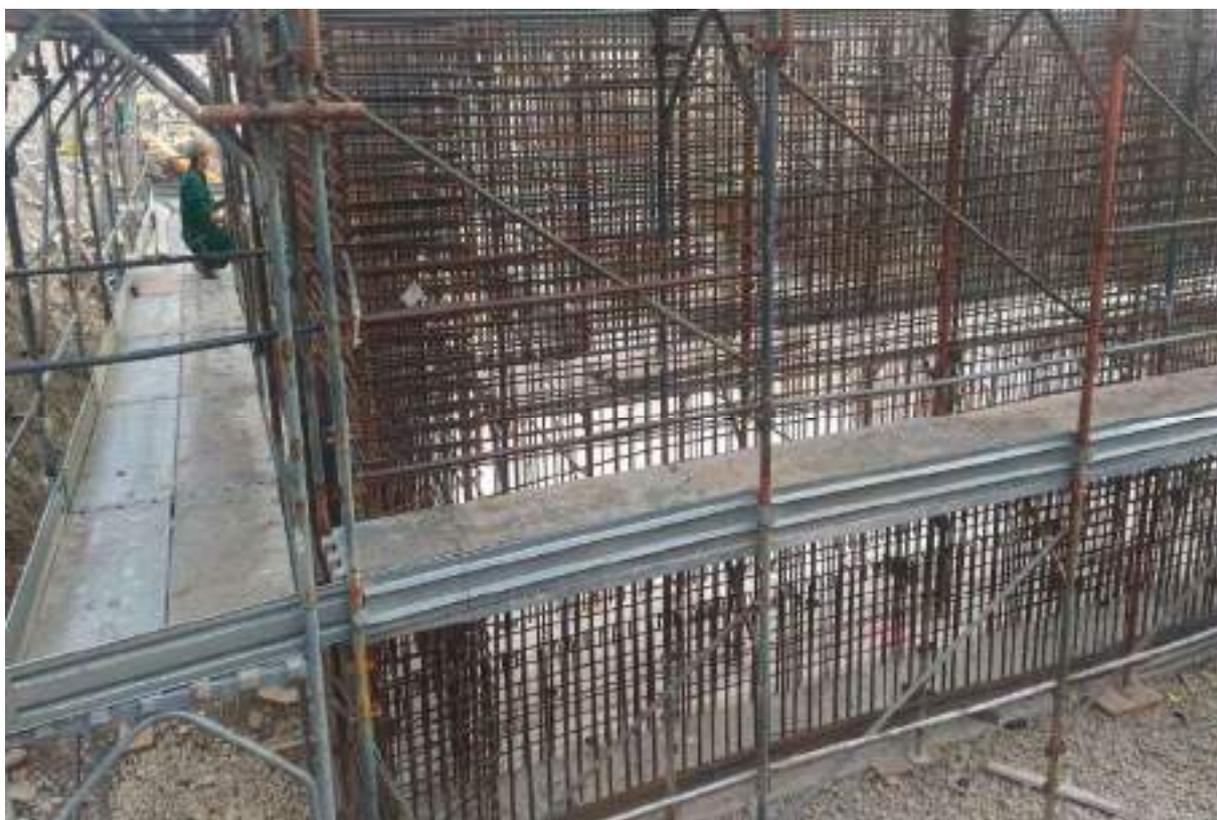
CENTRALE DI PRODUZIONE – MONTAGGIO FERRO ARMATURA MURI IN ELEVAZIONE
