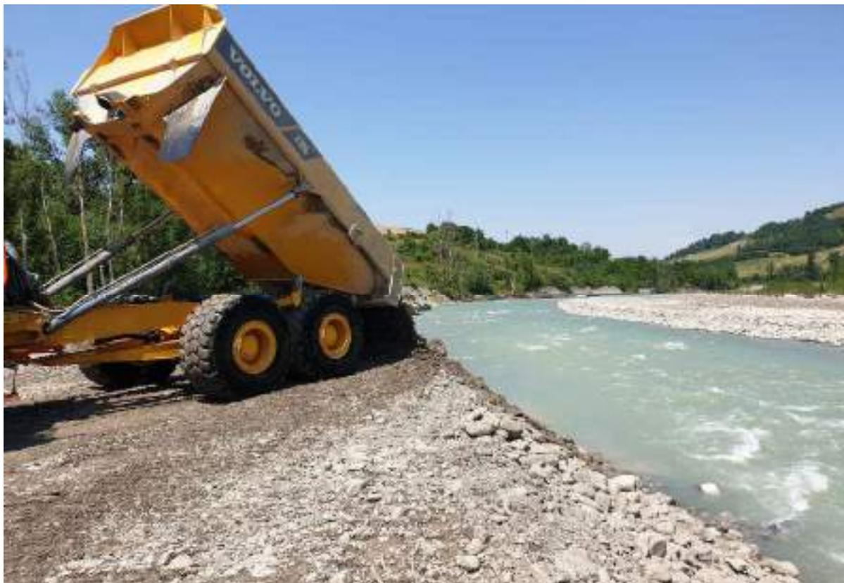
CANALE DI SCARICO A FIUME – FORMAZIONE ARGINE E CENTRALIZZAZIONE DELL'ALVEO
