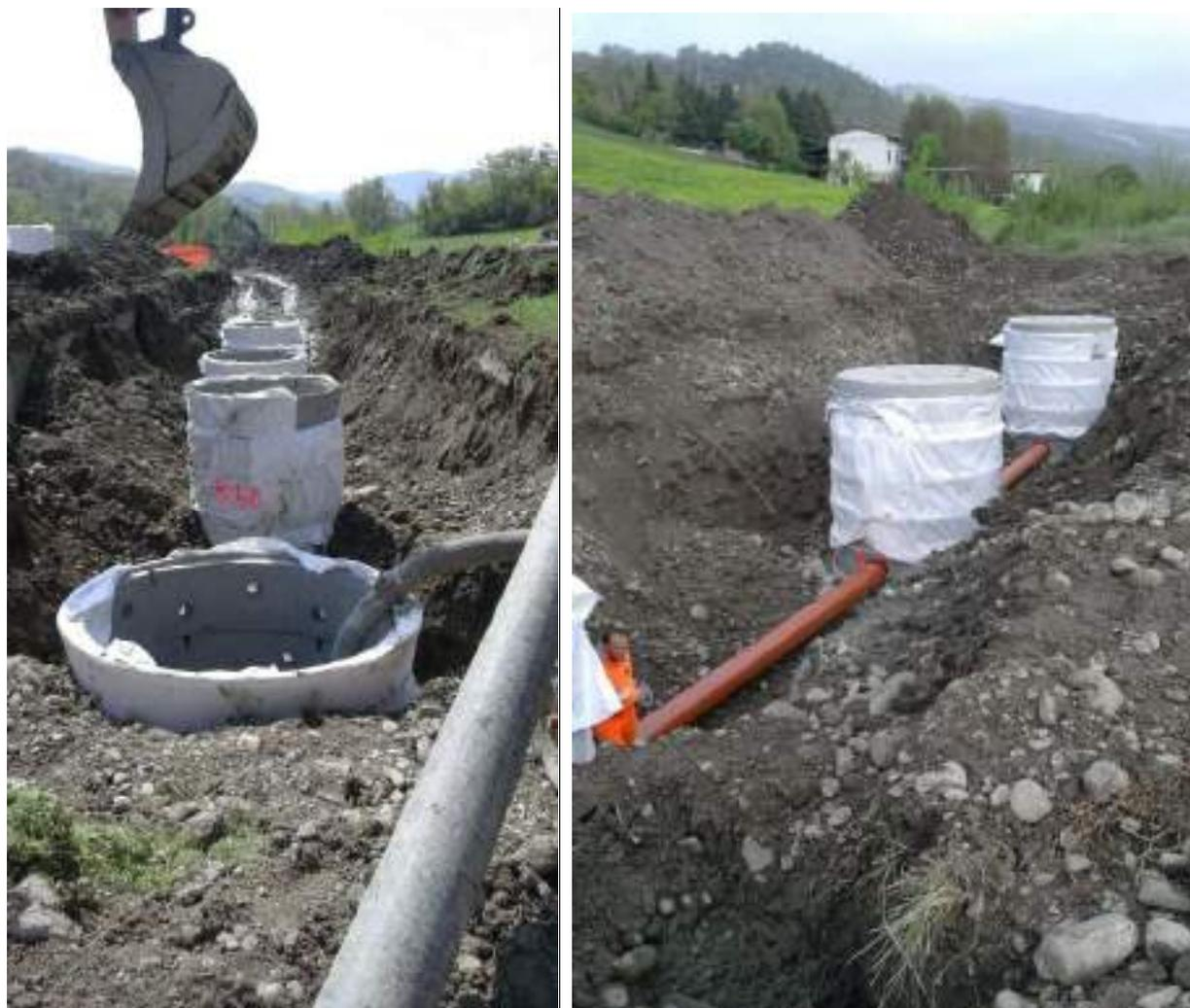
CANALE DI ADDUZIONE - POSA BATTERIA POZZI DISPERDENTI A MONTE DEL CANALE DI ADDUZIONE
