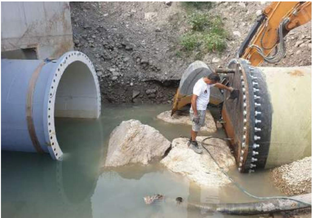
CONDOTTA FORZATA –IL COLAUDO DI TENUATA IDRAULICA
