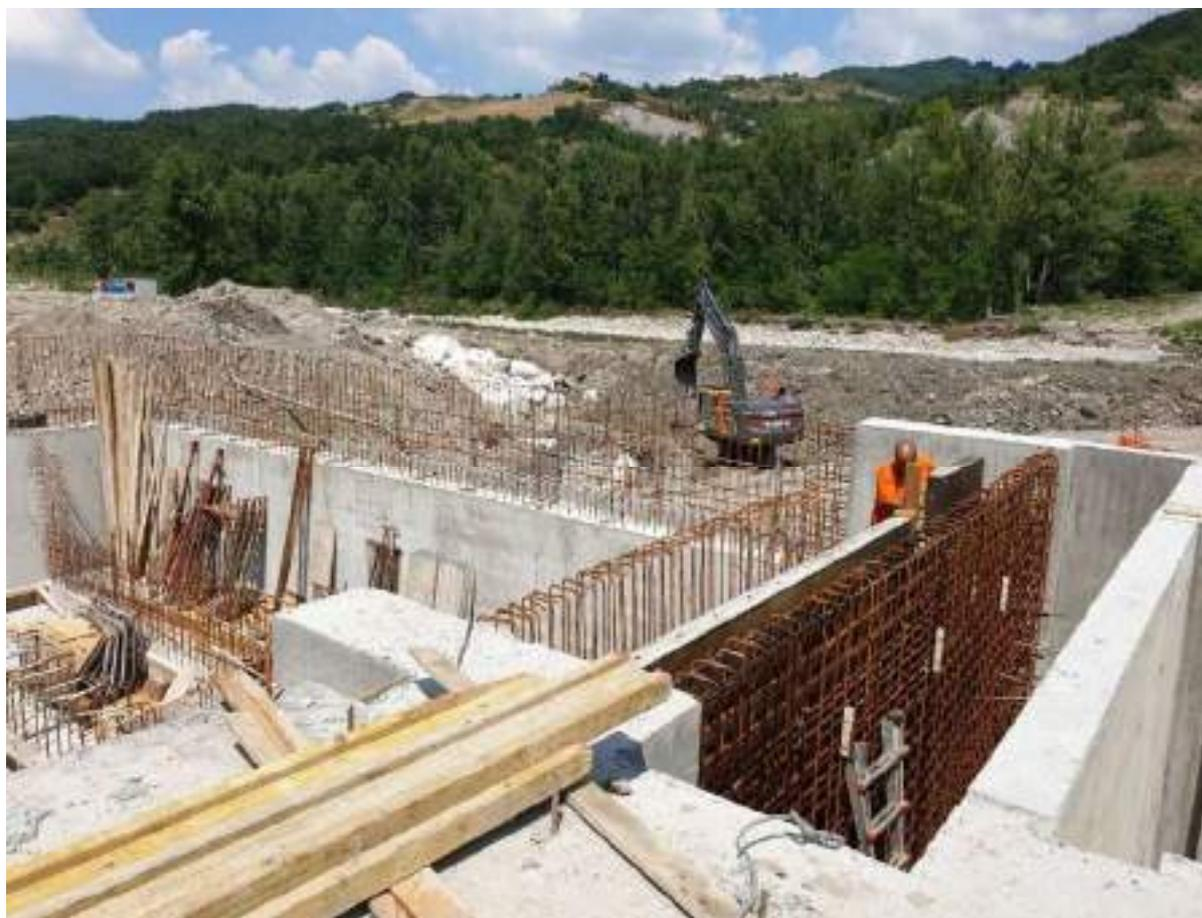
OPERA DI PRESA – FASE DI CASSERATURA E POSA FERRO ARMATURA II° ELEVAZIONE
