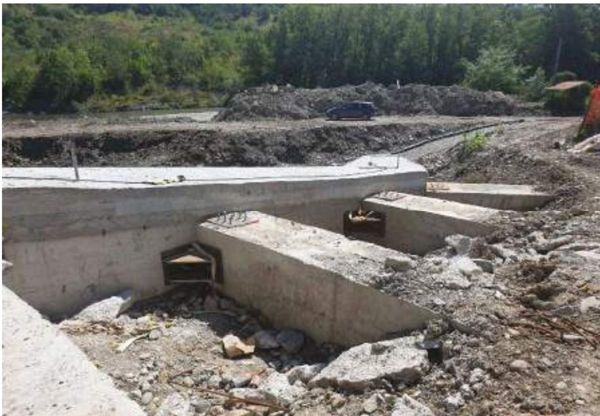
OPERA DI PRESA – PARAMENTO CANALE DI INVITO IRRIGIDIMENTI STRUTTURALI
